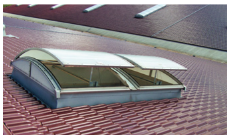
Eredeti szellőztető és füstelvezető nyílászárnyak (30 cm emelési magasság, kevesebb, mint 30% szabad keresztmetszet)
